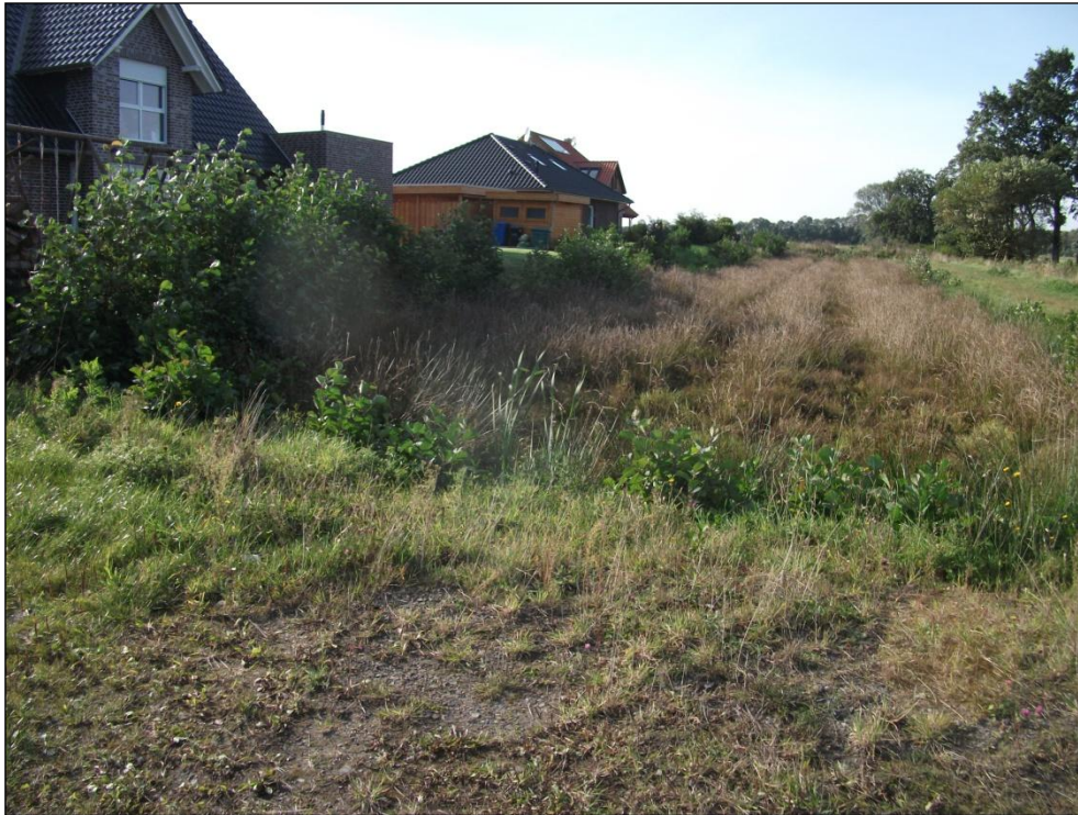
Abb. 2: Regenrückhaltebecken 1. Bauabschnitt (Blick nach Westen)
