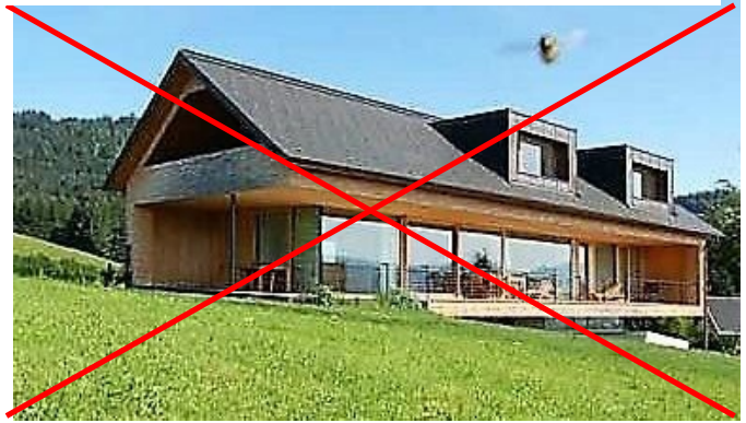
Unzulässige Fassadenaushöhlung
