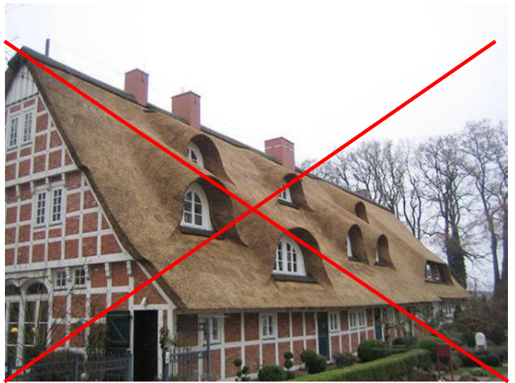
Große (ungeordnete) und unterschiedliche Gauben stören die großflächige Wirkung des Daches
