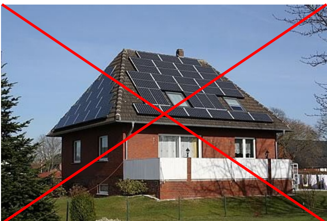
Wechsel der Panelausrichtung, Versatz der Panel-fugen, DF-Fenster stören die Anordnung, unterschiedliche Versätze am Grat etc.
