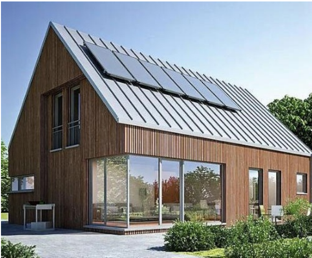
Gereihte und gut proportionierte Solarelemente erhalten die Dachflächenwirkung
