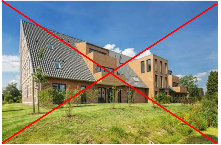
Voluminöse Ein- und Aufbauten zerstören das Dach und sind atypisch für Bauernhaustypen
