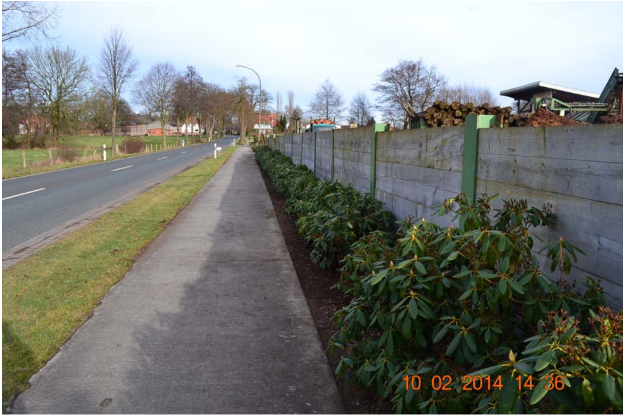
vorhandene Bretterwand an der K 4
