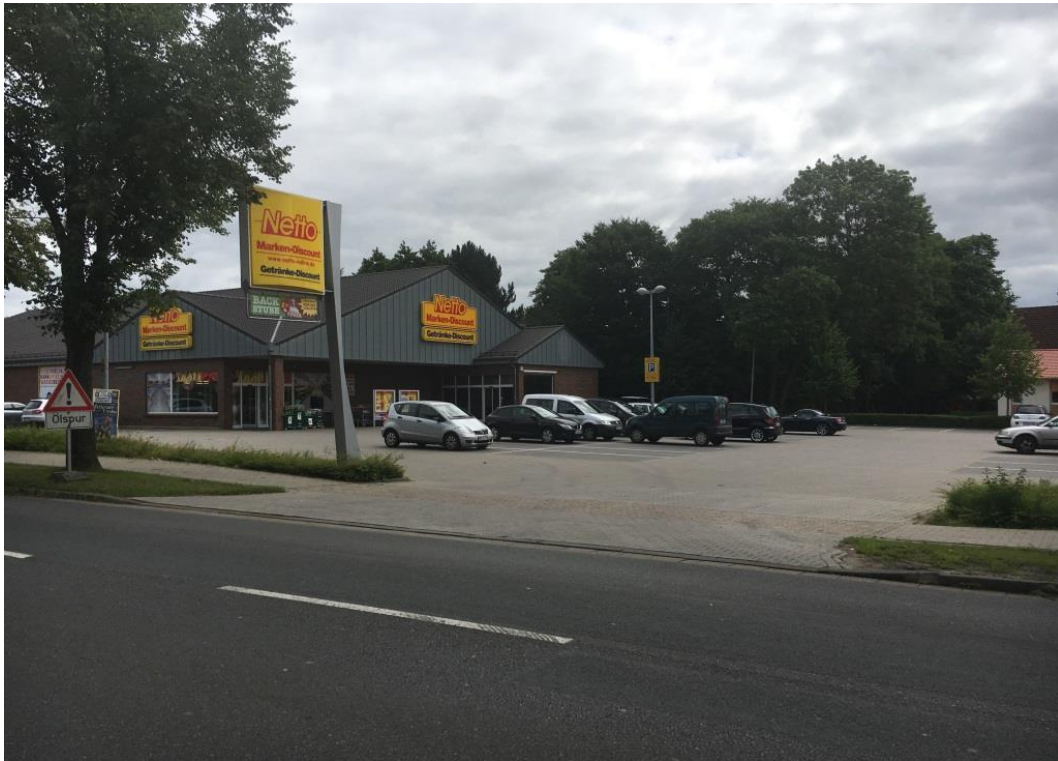
Abbildung 6: Blick auf die Einfahrt zum Netto-Markt
